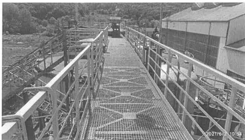
Rekonstrukce pochozích lávek na dekantérech chloridu vápenatém
