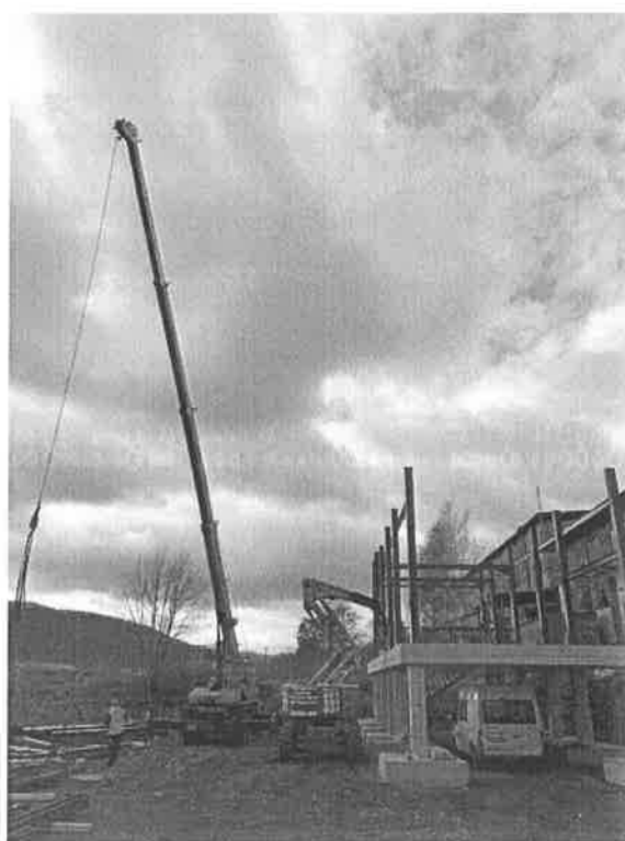
Rekonstrukce pochozích lávek na dekantérech chloridu vápenatém
